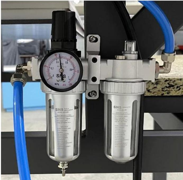
**Sistema di filtraggio dell'aria:** il sistema di filtraggio dell'aria integrato offre una migliore qualità dell'aria, protezione per i macchinari, riduzione della contaminazione, maggiore sicurezza e facilità di manutenzione.
