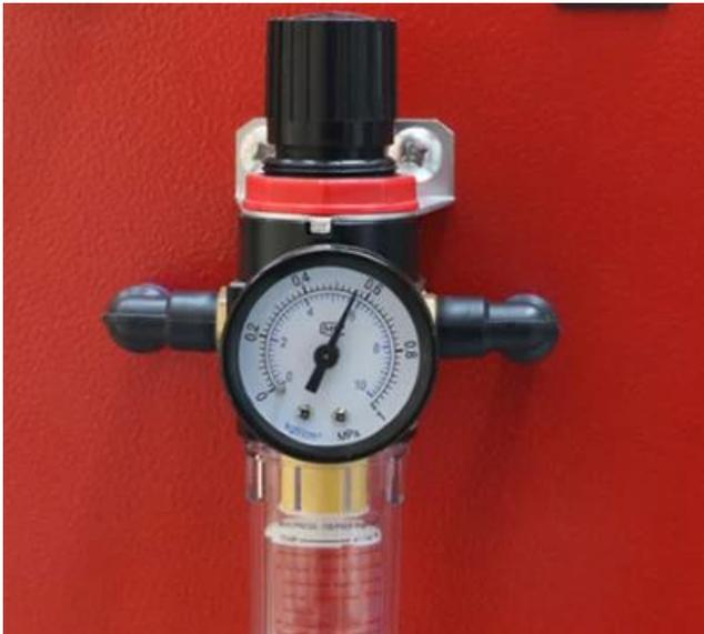
**Filtro dell'aria:** Per regolare la pressione della pressa di calore XPDS, facile da usare e da mantenere.
